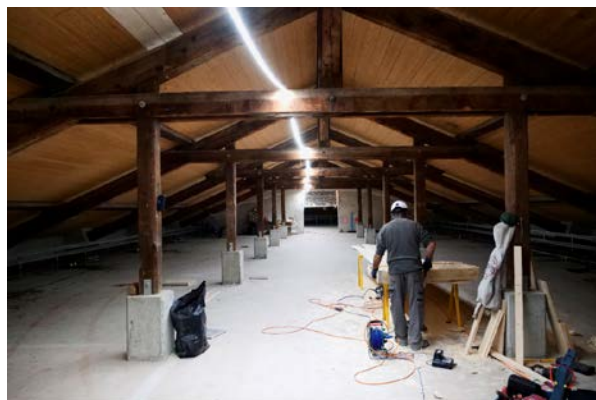
Chantier du nouvel Hôtel des archives septembre 2022
