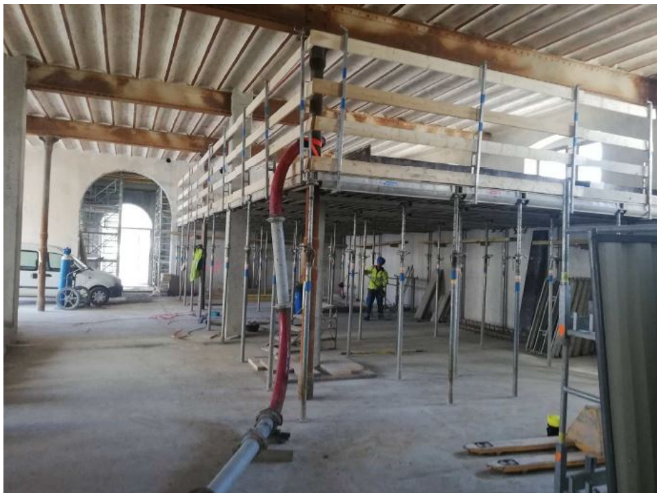
Chantier du nouvel Hôtel des archives mars 2022
