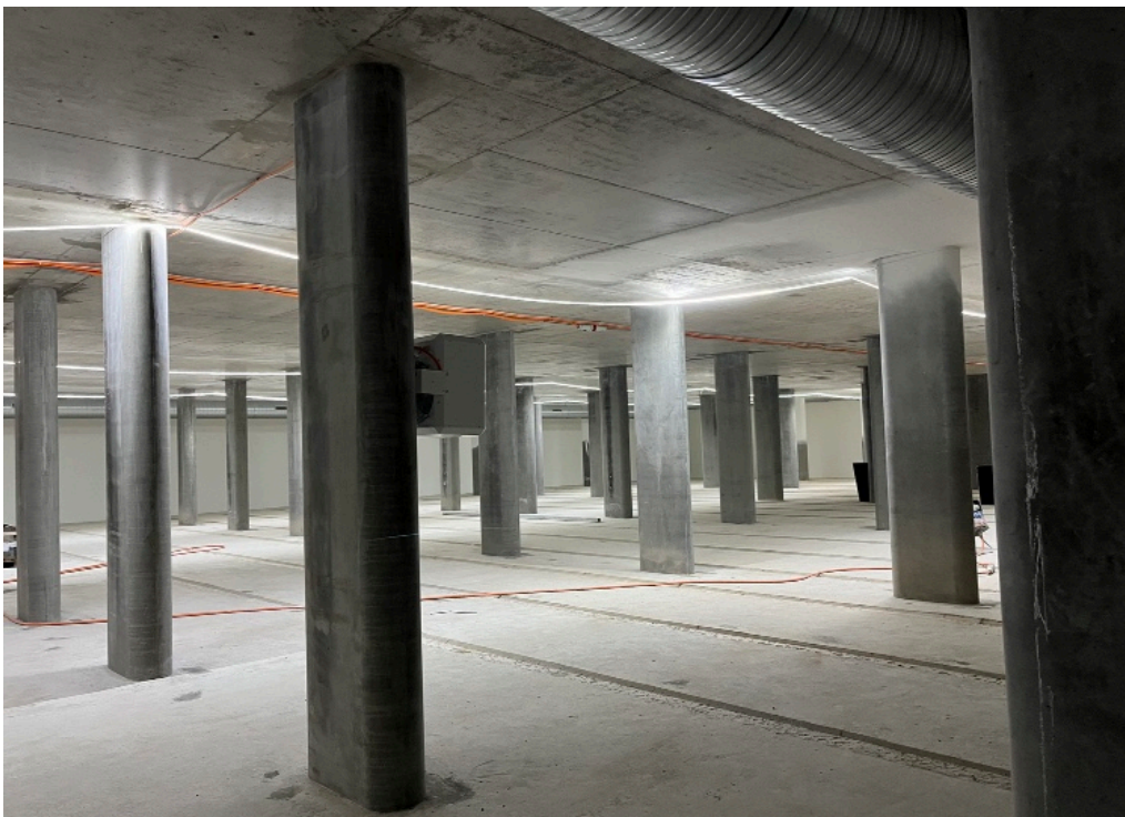
Chantier du nouvel Hôtel des archives septembre 2022
