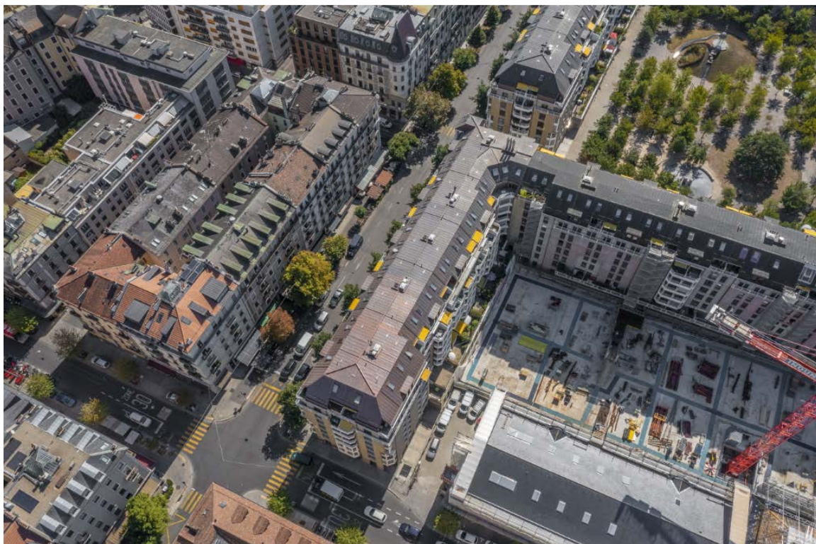
Chantier du nouvel Hôtel des archives septembre 2022
