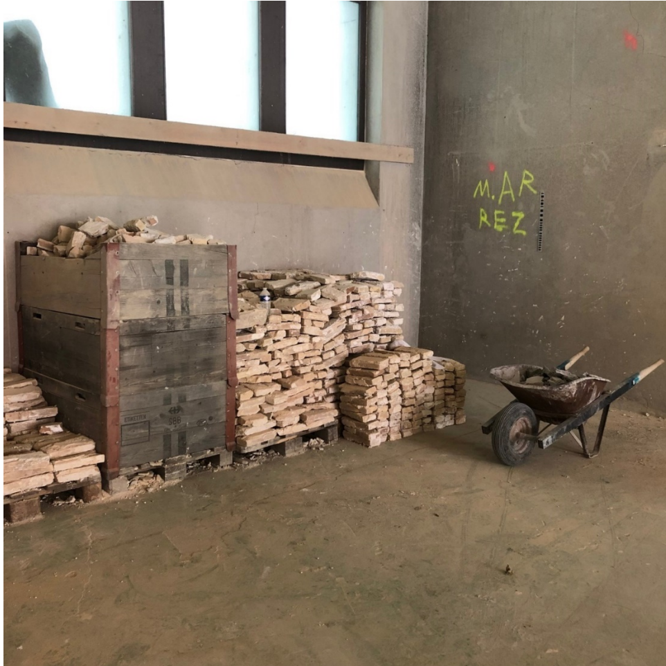
Chantier du nouvel Hôtel des archives : briques constituant les voûtains septembre 2022
