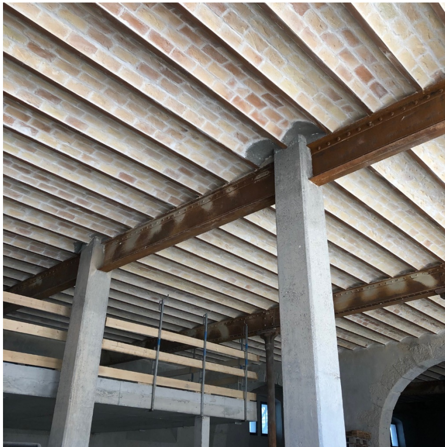
Chantier du nouvel hôtel des archives septembre 2022
