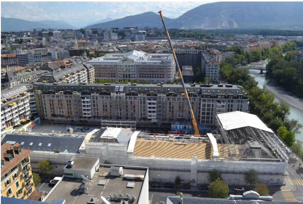
Chantier du nouvel Hôtel des archives septembre 2022
