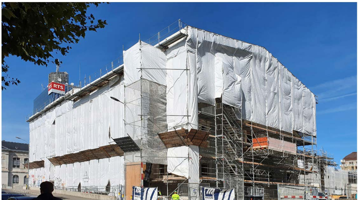
Chantier du nouvel Hôtel des archives septembre 2022
