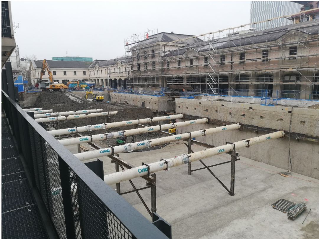
Le chantier du nouvel Hôtel des archives décembre 2021
